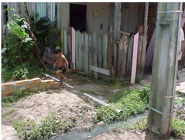
Fotografia 33: Detalhe do desaguamento do esgoto sanitário na vala de drenagem na Rua 10 de Maio I
