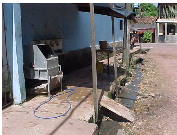
Fotografia 18: Detalhe da contribuição do efluente do abatedouro em frente à casa nº 25
