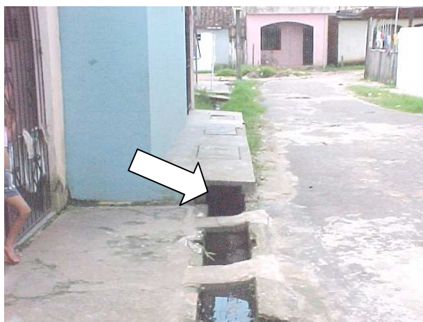
Fotografia 32: Detalhe do desaguamento do esgoto sanitário na vala de drenagem da Rua “E”
