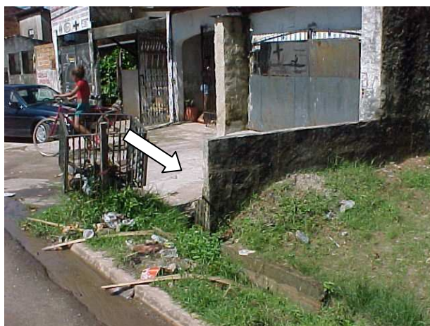
Fotografia 11: Residência nº 09 - seta indicando o local do tanque séptico enterrado na entrada da casa
