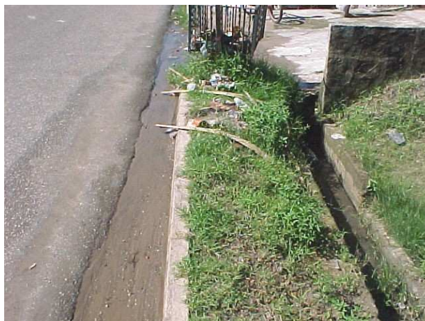
Fotografia 12: Detalhe do meio-fio e da vala de drenagem em frente à casa nº 09
