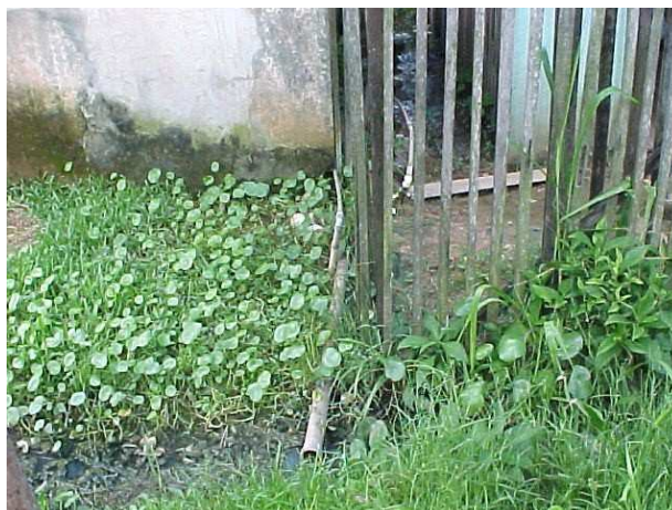
Fotografia 27: Detalhe do desaguamento do esgoto sanitário da casa nº 141
