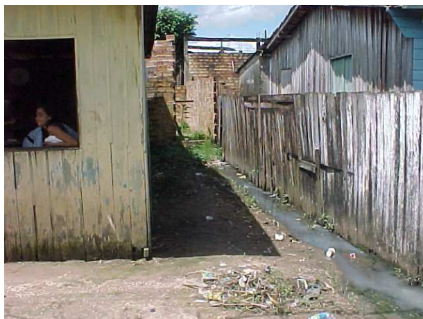
Fotografia 31: Detalhe do escoamento do esgoto sanitário da casa nº 65
