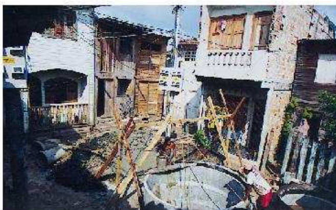
Fotografia 6: Construção de tanque séptico coletivo
