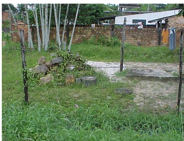
Fotografia 24: Tanque séptico e caixa de ligação no quintal da residência nº 15, na Passagem Manoel Pinho
