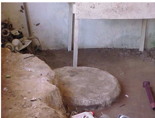
Fotografia 20: PV não ativado, localizado no pátio da casa nº 167
