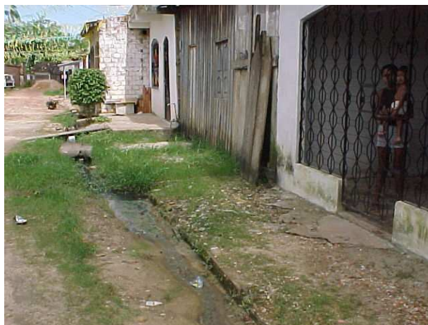
Fotografia 23: Na Passagem Santa Inês II, nº 20 a contribuição é diretamente em uma vala de drenagem no leito da via
