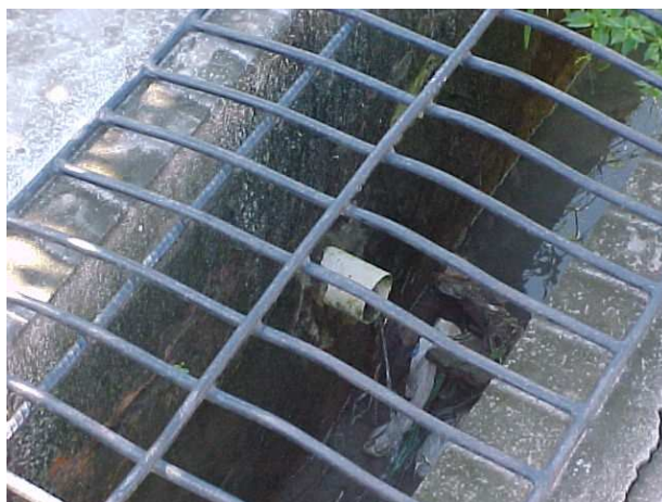
Fotografia 13: Contribuição na vala de drenagem em frente a casa nº 10
