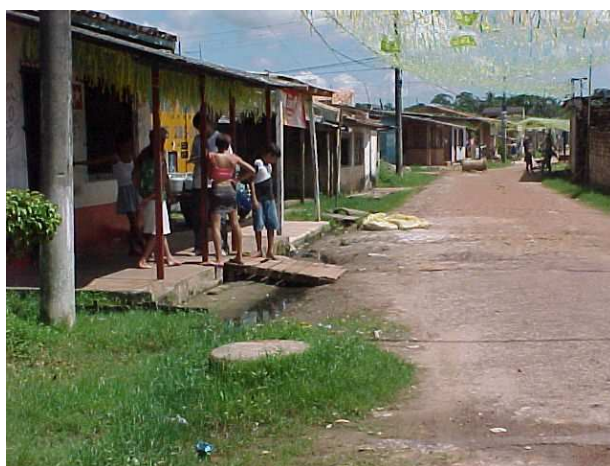
Fotografia 35: PV localizado na Passagem Iracema, em frente à casa nº 05. Apenas o morador desta casa o utiliza
