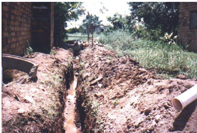
Fotografia 8: Assentamento do ramal condominial
