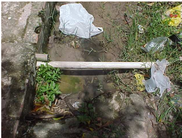
Fotografia 25: Ligação do tanque séptico com a rede básica na Passagem Manoel Pinho nº 44
